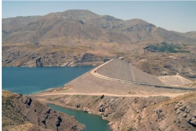
شکل (۱-۱۸): سد طالقان از نوع خاکی با هسته رسی به ارتفاع ۱۰۳ متر در استان البرز
