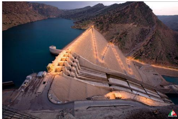
شکل (۱-۱۳): سد سنگریز با هسته رسی مسجدسلیمان به ارتفاع ۱۷۷ متر
