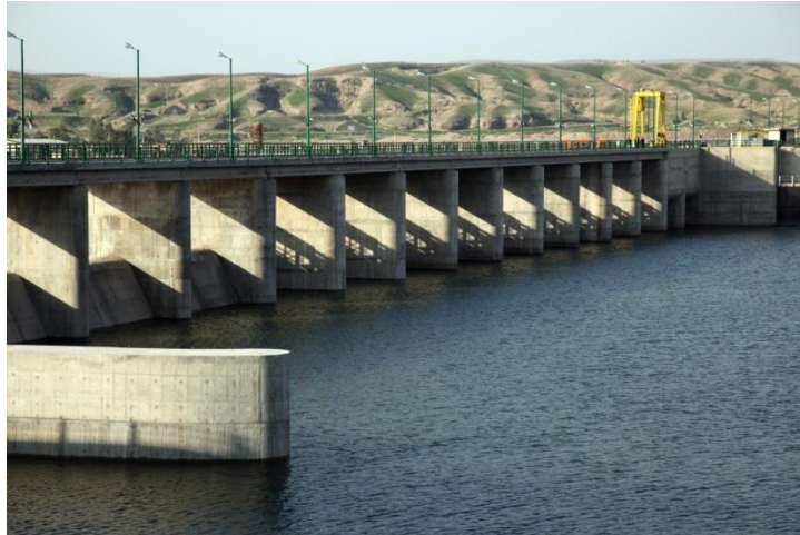
شکل (۷-۱): سد انحرافی تنظیمی پای پل در خوزستان
