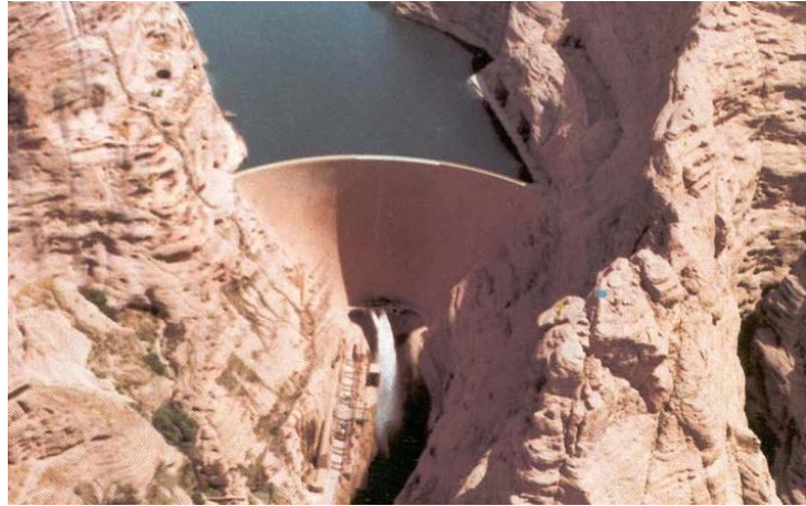
شکل (۱-۱۲): سد بتنی دو قوسی دز در شمال خوزستان به ارتفاع ۲۰۳ متر در سال ۱۳۴۲ ساخته شده است.
