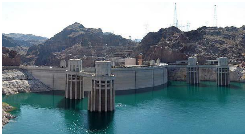
شکل (۵-۲): سیستم آبیگری از مخزن سد
