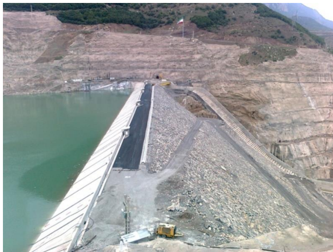
شکل (۱۴-۱): سد سنگریز با رویه بتنی سیاه‌پیشه به ارتفاع ۸۵ متر در میانه جاده کرج - چالوس
