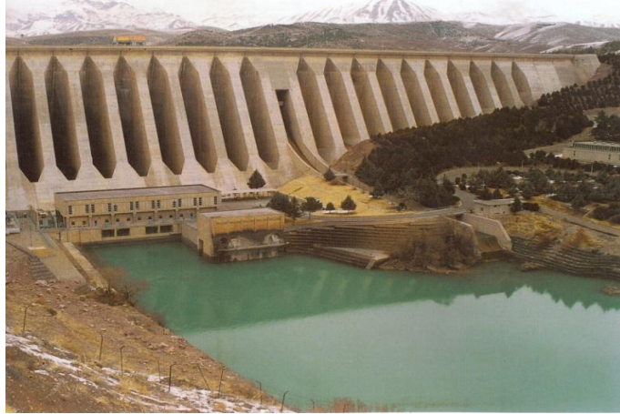
شکل (۱۶-۱): سد لتیان از نوع بتنی وزنی پشت بنددار به ارتفاع ۱۰۷ متر در اطراف تهران
