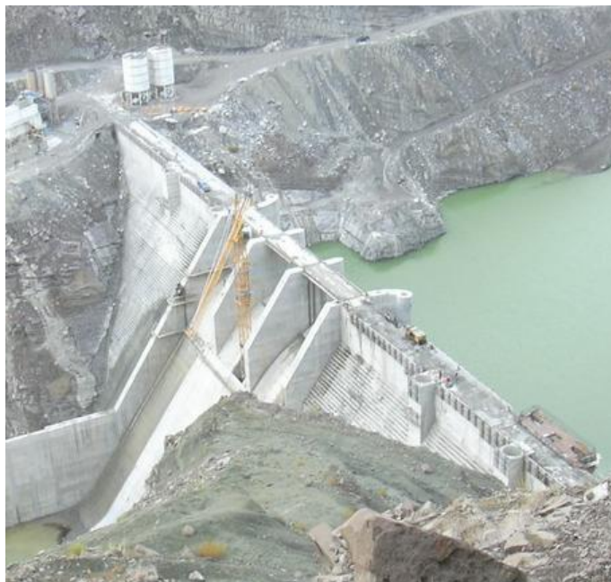
شکل (۱-۱): سد جگین در استان هرمزگان از نوع بتن غلطکی به ارتفاع ۷۸ متر
